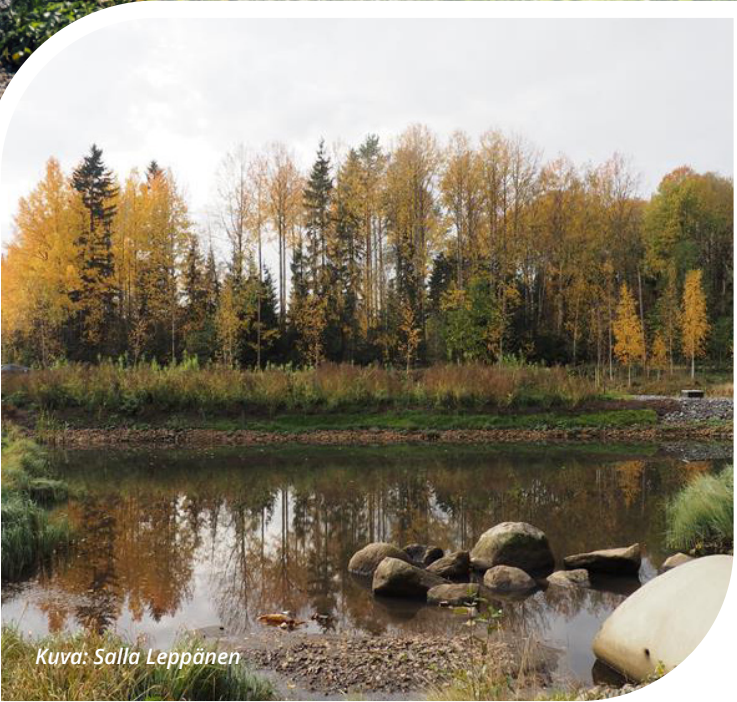
Kuva 21 Etuhaanpuistoon on rakennettu hulevesialtaat ja suotopenger Hervannan hulevesien puhdistamiseen ja viivyttämiseen. Suotopenkereessä on käytetty suodatinmateriaalina muun muassa kevytsoraa, joka poistaa hulevedestä epäpuhtauksia. Lisäksi altaissa on vesikasvimattoja, joka sitoo ravinteita hulevedestä. Tutkimusten mukaan järjestelmä pidättää keskimäärin 65 prosenttia kiintoaineesta. Hulevesikohde toimii samalla elinympäristönä muun muassa vesilinnuille, karpalle ja vesimyräälle.
